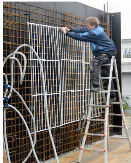
Oberflächennahe Verlegung für hohe Reaktionsgeschwindigkeit. Große Flächen / Heizkreise durch günstige Hydraulik (Tichelmann)
